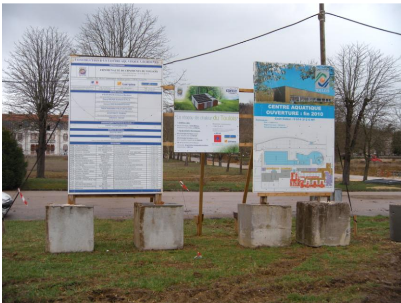
Les travaux en cours sur le site de l'ancienne caserne Thouvenot (avril 2010)
